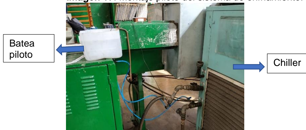
Imagen 17. Montaje piloto del sistema de enfriamiento.
