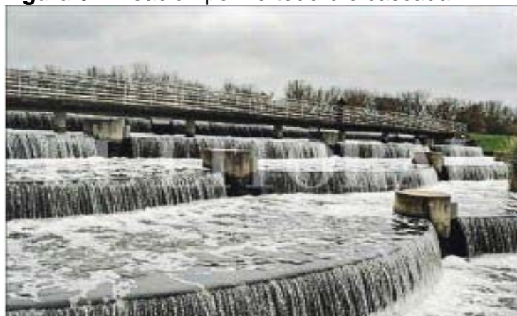
Figura 5. Aireación por vertedero o cascada.
