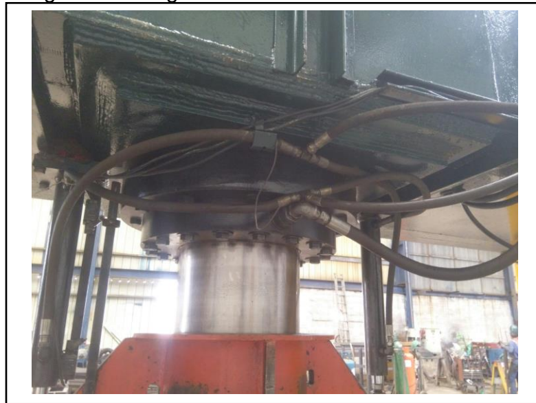
Imagen 28. Mangueras de embombadora
