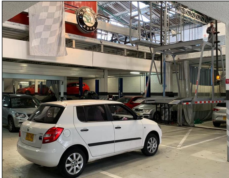
Imagen 13. Ascensor de vehículos
