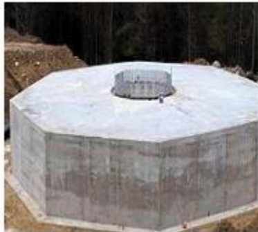
Figura 83. Construcción de la cimentación
