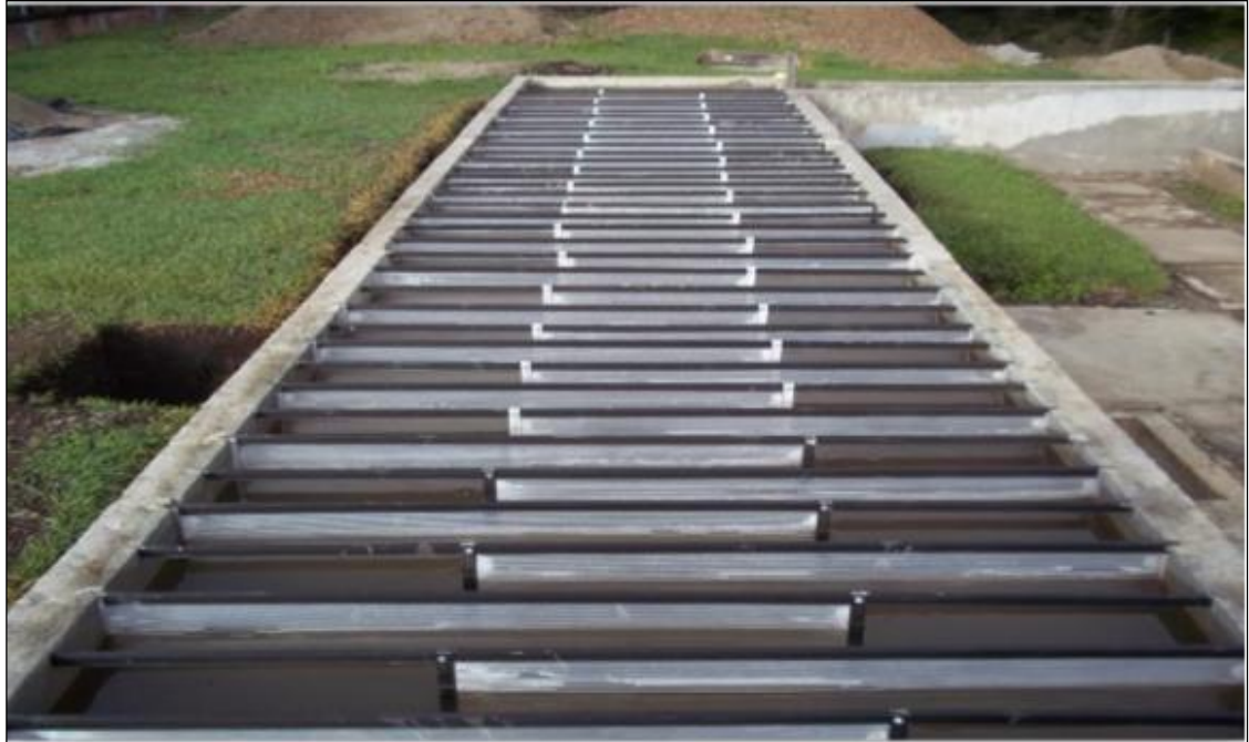
Figura 7. Floculador de pantallas de flujo horizontal.
