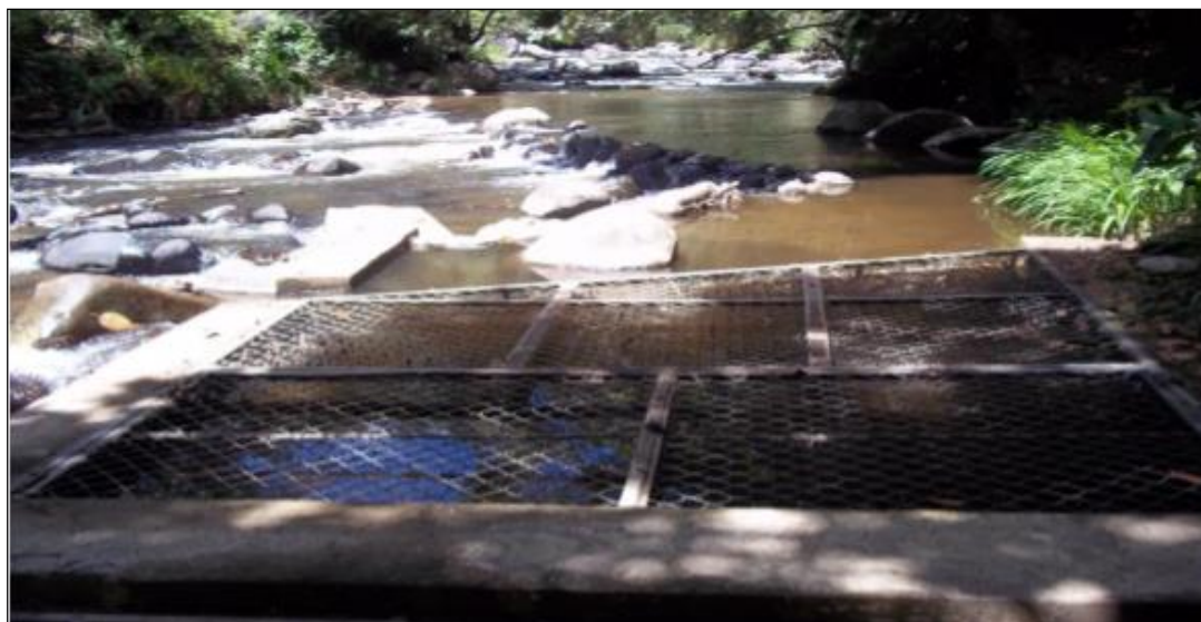
Figura 3. Captación de agua en el acueducto La Venta el Cofre.
