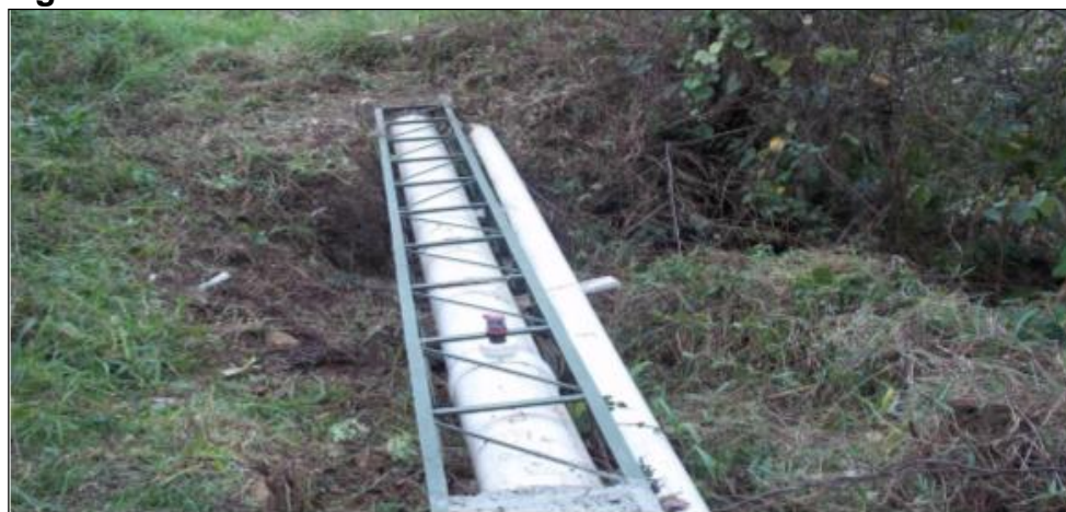
Figura 4. Viaducto tubería de aducción.
