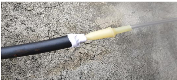
Ilustración 24. Conexión manguera- equipo de goteo
