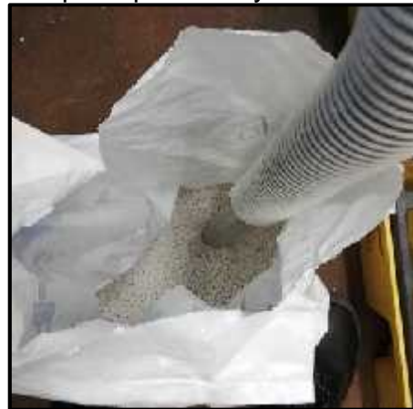
Imagen 32. Succión del material completo para la inyección.
