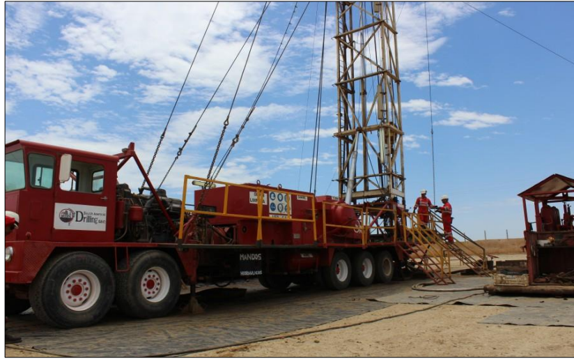
Figura 10. Camión equipo de Workover.
