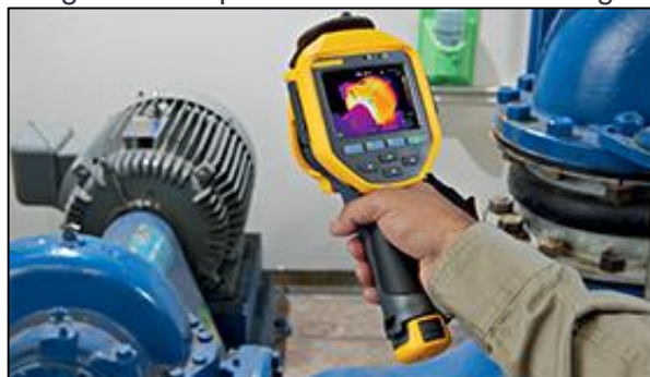
Imagen 48. Inspección con cámara termografía
