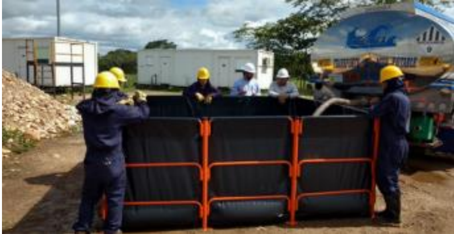
Figura 15. Llenado de fast tank con agua suministrada por carro tanque
