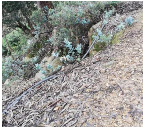
Imagen 13. Área entre el punto 1 y 2, intervención con mangueras.
