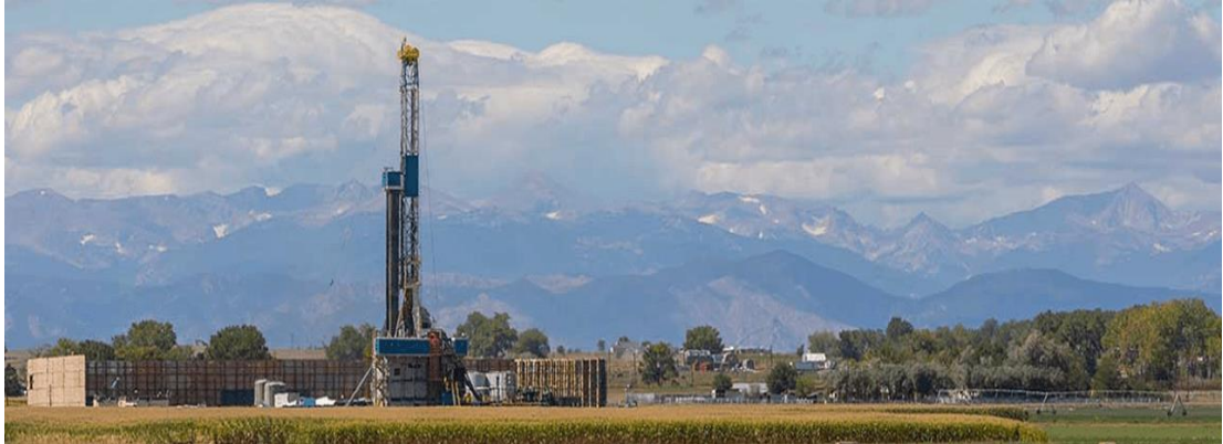
Imagen 1. Taladro de perforación PACE
