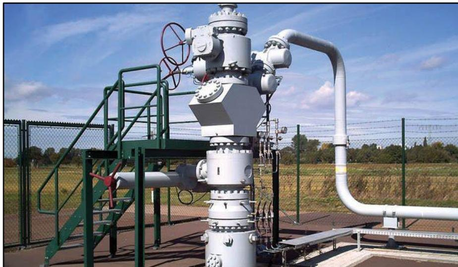
**Nota.** Cabezal de pozo en producción. Todo equipo empleado en *Well testing* ha sido retirado de la locación. Tomado de ROGTEC. <https://rogtecmagazine.com/rpi-downhole-and-wellhead-equipment-market-prospects-new-technologies-impact-of-sanctions/>
