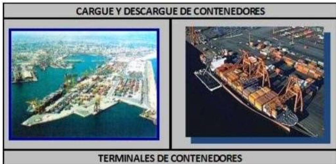
Figura 10. Terminal de contenedores
