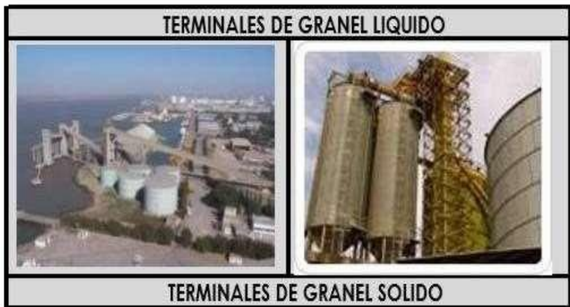
Figura 8. Terminal de granel sólido
