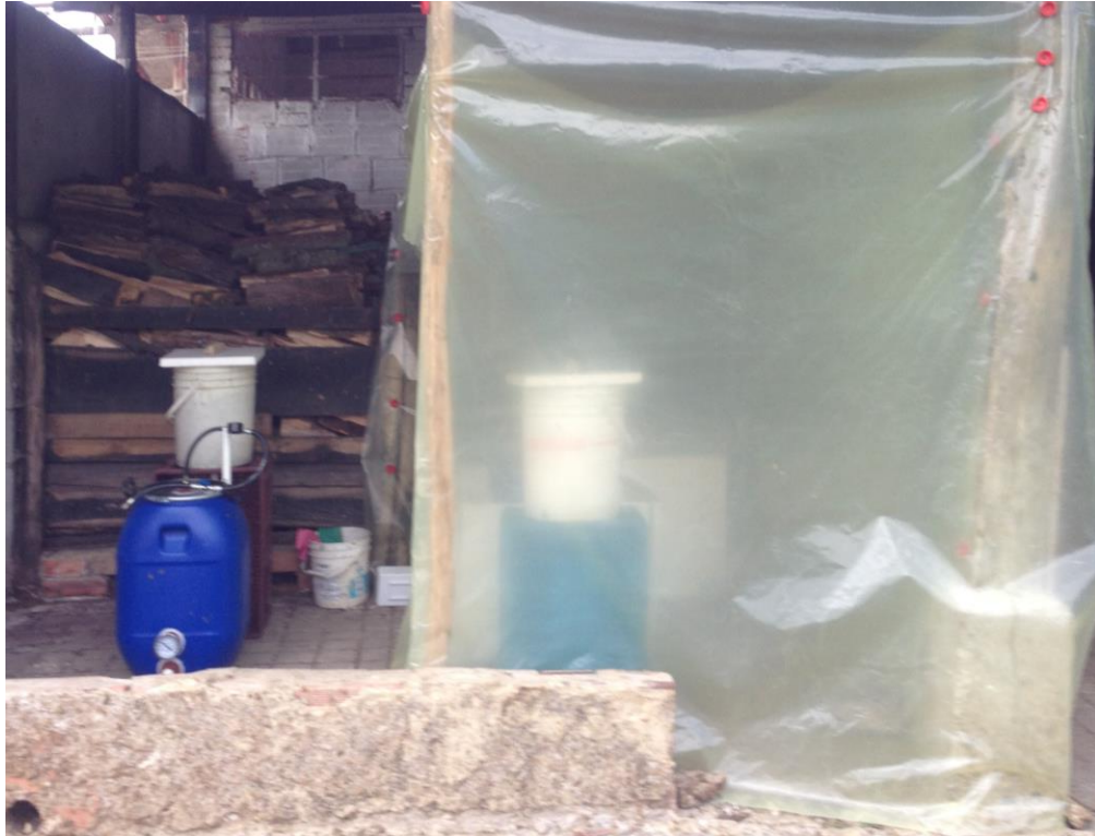
Ilustración 8. Construcción finalizada de los digestores.
