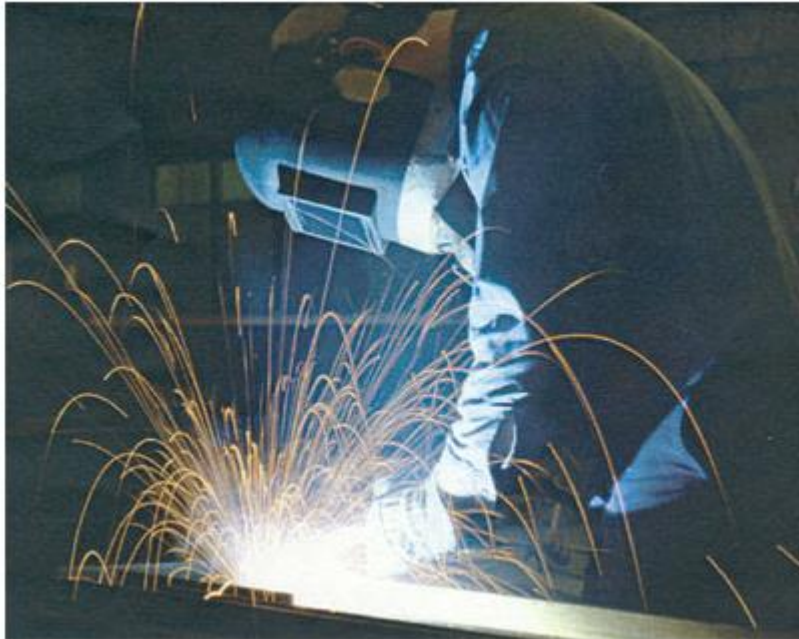
Imagen 102. Proceso de soldadura
