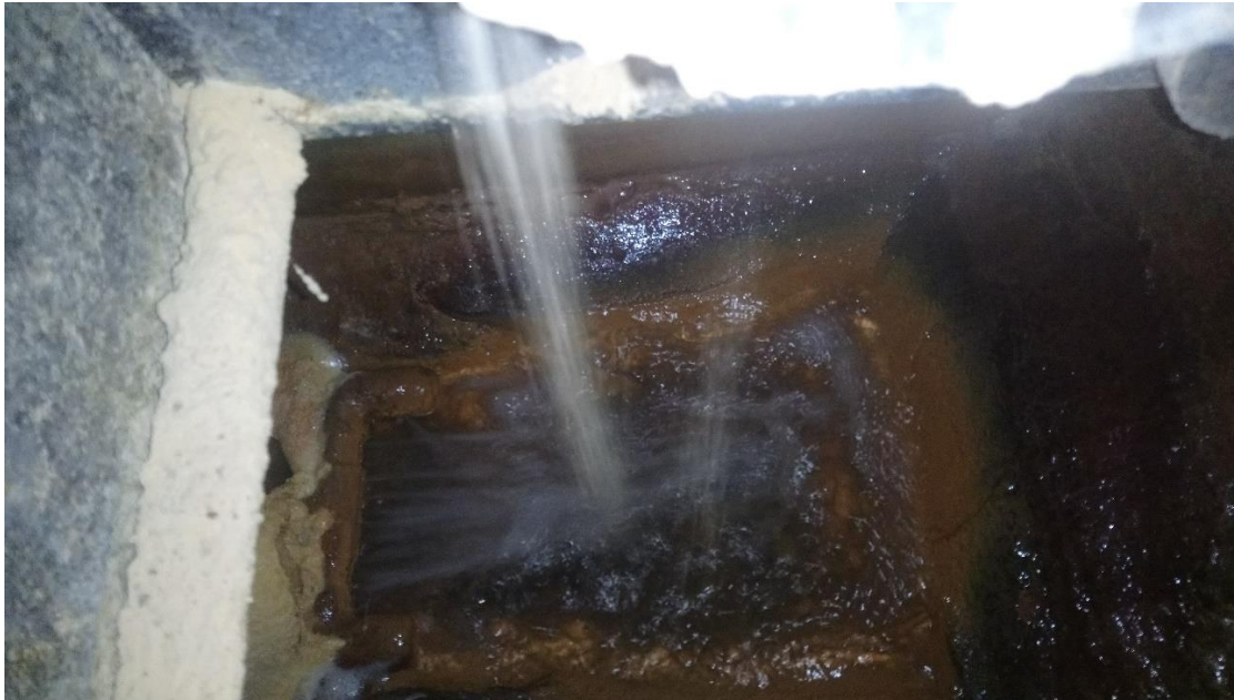
Figura 6. Punto de mezcla entre agua y el coagulante
