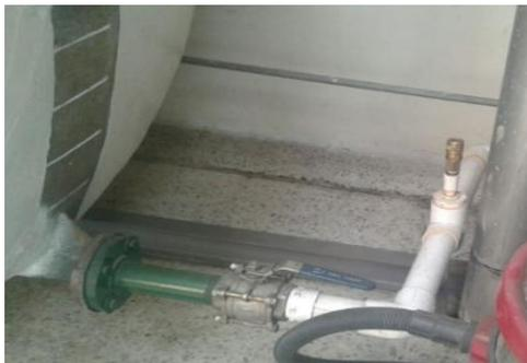
**Figura 48.** Interconexión de tubería de entrada
