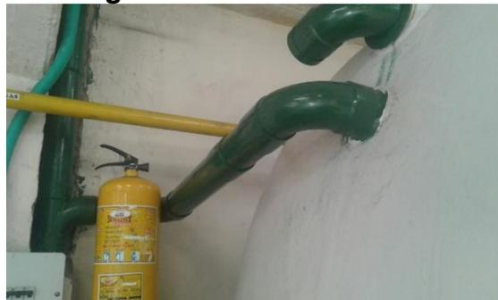
El medidor de nivel (figura 50) controla el nivel del agua que entra al tanque de agua lluvia, teniendo como volumen final 5100 L y no 6000 L, sin el medidor las canaletas de la planta y las tuberías de entrada del tanque colapsarían por la cantidad de agua, este también ayuda a que el tanque no esté hermético, sino que entre el agua en contacto con el oxígeno, en la figura 50 el medidor es la tubería verde.
