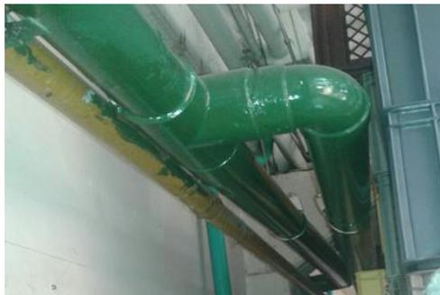
La interconexión (Figura 48) es importante de mencionar, ya que antes del tanque se requiere un filtro para retirar sólidos, por lo cual se debe tener en cuenta que hay dos tuberías que llenan el tanque, estas afectarían la presión a la que se verá sometido el filtro para poder fluir el agua lluvia al tanque.
