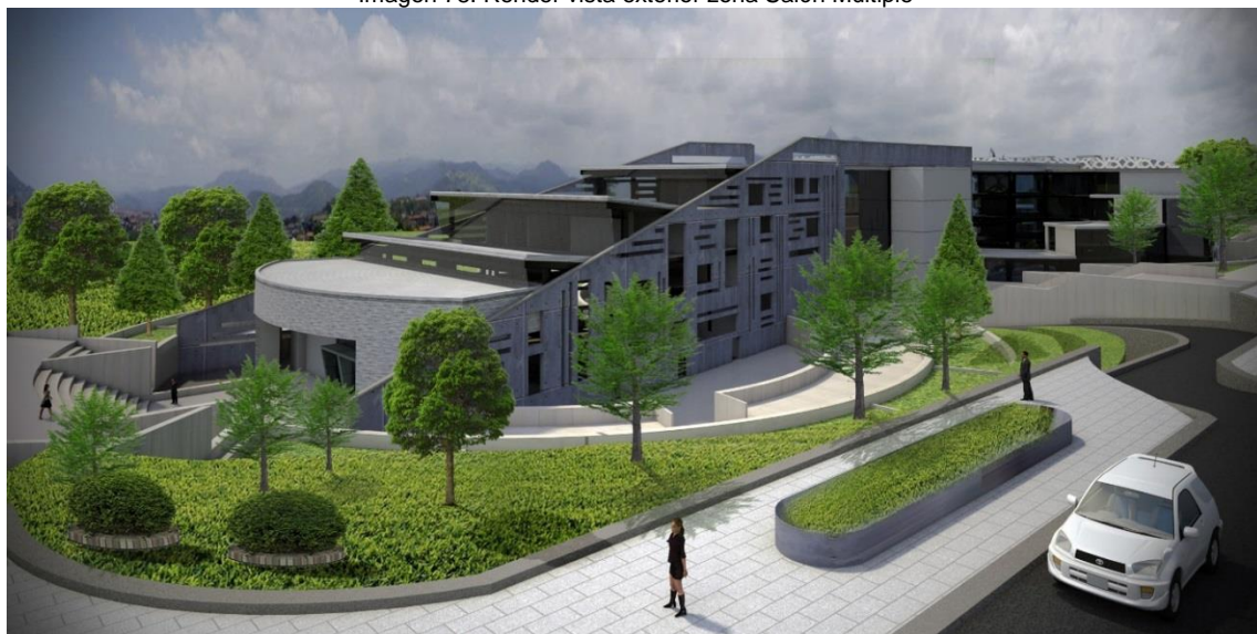
Imagen 78. Render vista exterior zona Salón Múltiple
