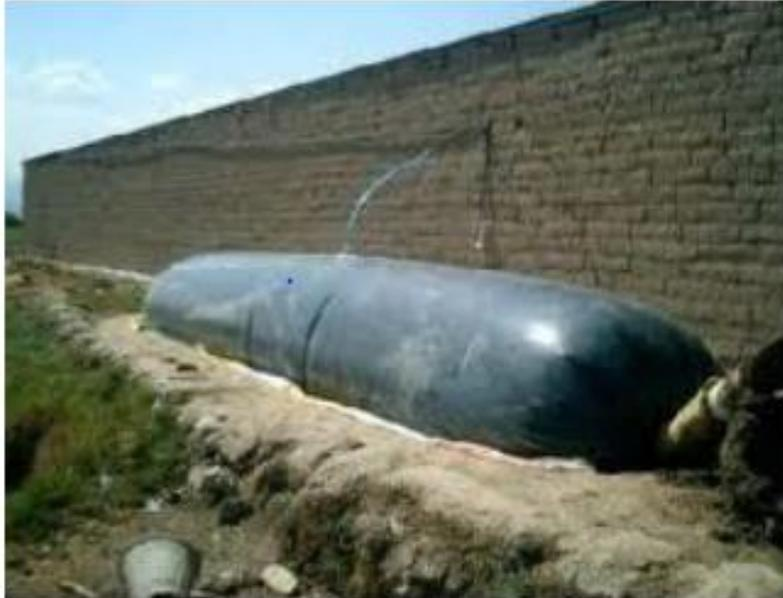
**Nota.** Esta imagen muestra el esquema de biodigestor de estructura flexible. Tomado de (Arenas Guayazan, 2019)
