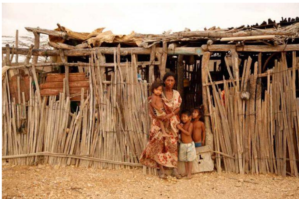
Figura 2. Condiciones actuales de la vivienda Wayuu.
