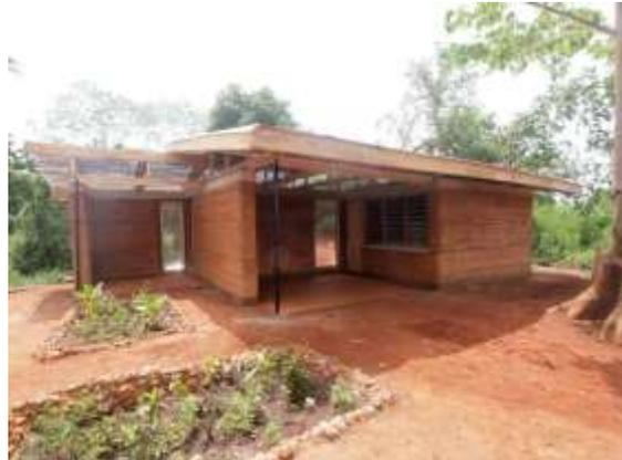
*Nota.* En la ilustración se muestra un ejemplo de arquitectura realizada con bloques de tierra comprimido y los veneficios que lleva utilizar este método de construcción económico y de fácil acceso, con aplicación a muchos campo y formas Tomado de: Vendrell, Felici (20 de junio 2015)
