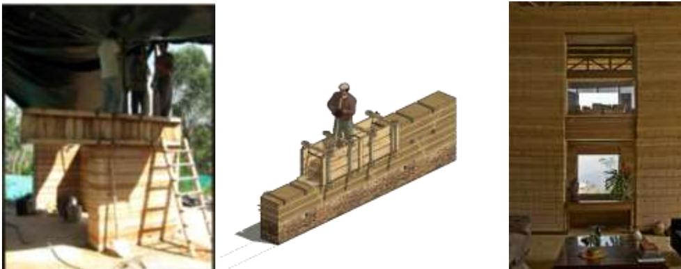
*Nota.* Técnicas de construcción implementadas: tapia pisada, bloque de tierra comprimido o bahareque. Recubrimientos en tierras naturales Tomado de Fundación Tierra Viva (06 de octubre 2009) Link: <http://www.fundaciontierraviva.org/2009/11/la-aldea-casa-posada-moreno/>
