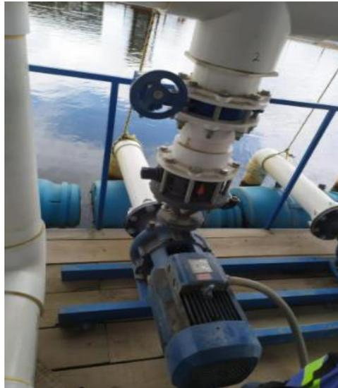
**Nota:** Bomba Pedrollo con sistema hidráulico en PVC.
