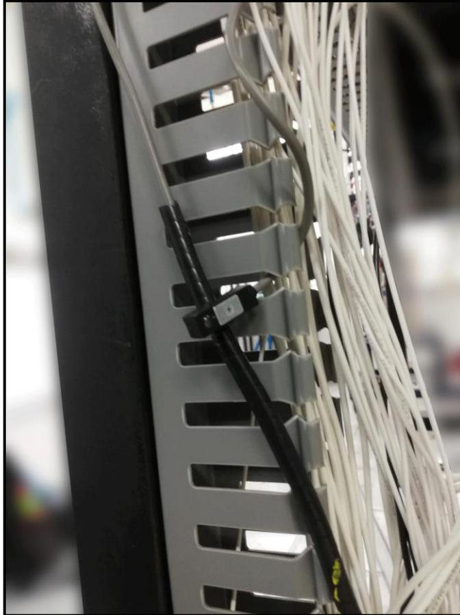
**Nota.** En la figura se observa la disposición de uno de los sensores reed y se evidencia su montaje innecesario.
