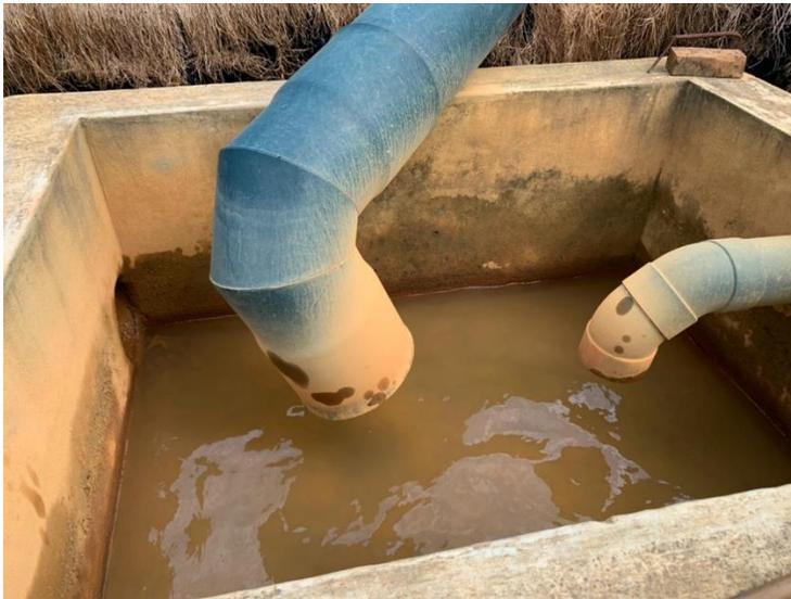
**Nota.** El agua de retrolavado llega por los dos tubos que se observan en la fotografía, correspondiéndole para el tubo más grueso el agua de retrolavado para las plantas de tipo compacto y para el tubo más delgado para la planta de tipo convencional.
