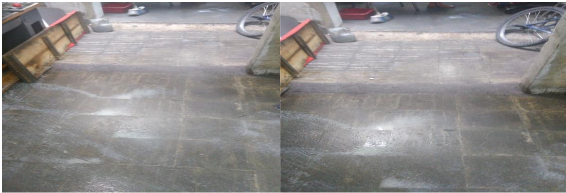
Pasillo en Planta Despejado
