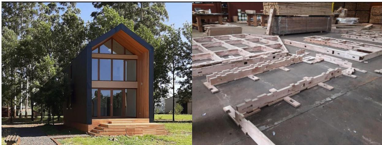
**Nota.** Esta figura muestra el prototipo de vivienda auto construible por medio de piezas en madera. Tomado de: Maiztegui, (2020). Link: <https://www.archdaily.co/co/938783/prototipos-de-viviendas-en-madera-soluciones-prefabricadas-como-alternativa-al-deficit-habitacional>
