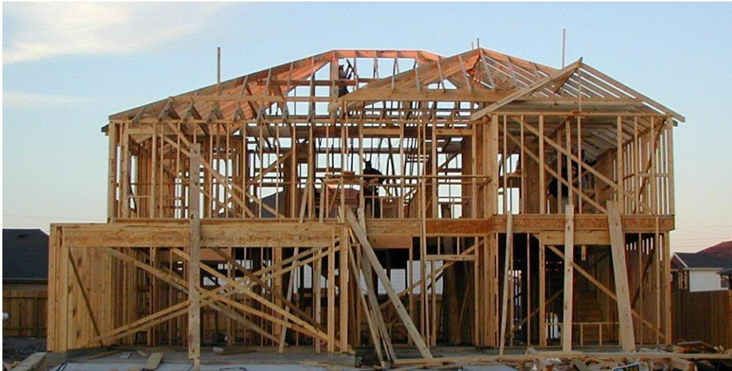
**Nota.** La figura representa una construcción hecha con el sistema Balloon Frame un sistema realizado en madera y con elementos prefabricados. Tomado de: Balloon Frame, (2008). Link: [https://es.wikipedia.org/wiki/Balloon\\_frame](https://es.wikipedia.org/wiki/Balloon_frame)
