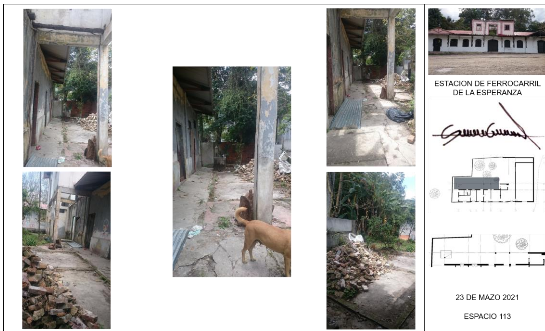
Nota. Registro fotográfico espacio 113.
