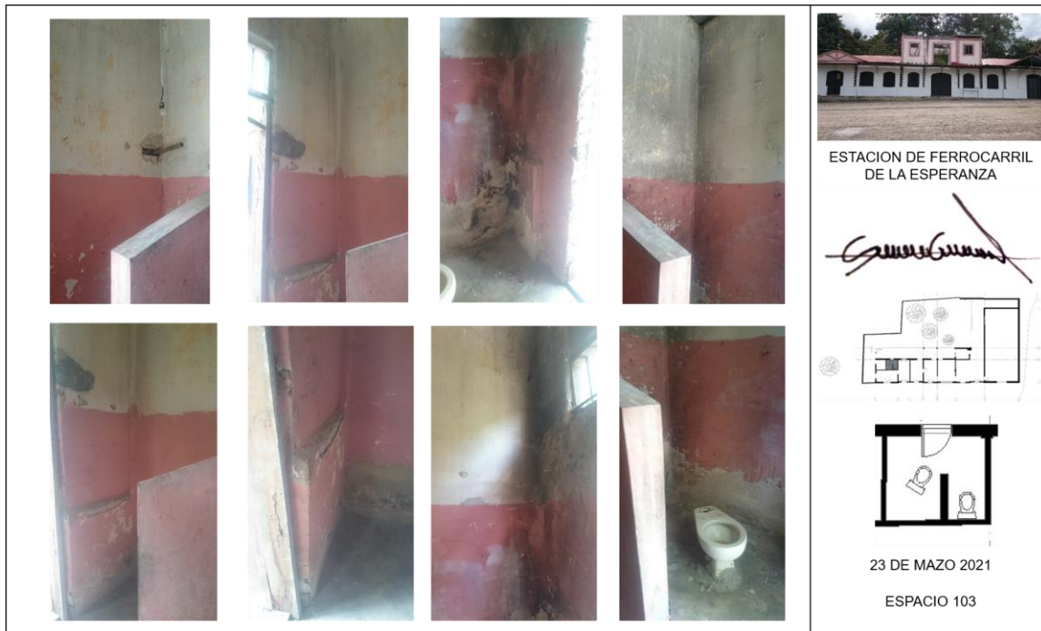
Nota. Registro fotográfico espacio 103.
