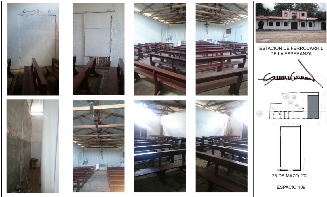
Nota. Registro fotográfico espacio 109.
