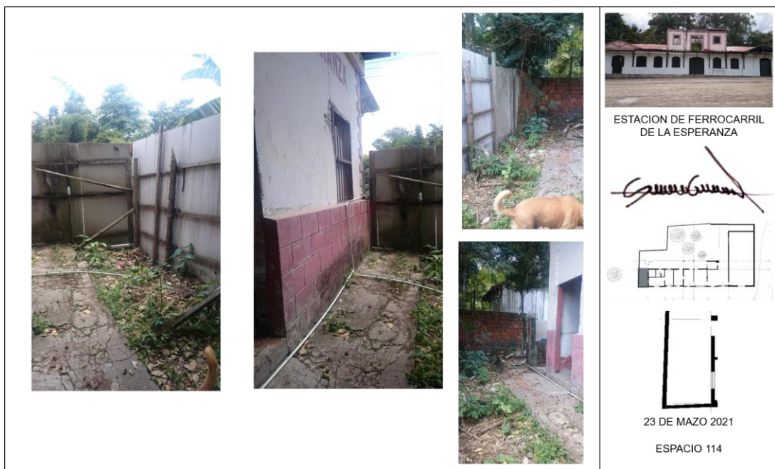
Nota. Registro fotográfico espacio 114.
