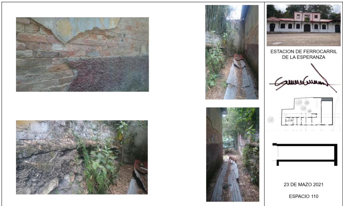
Nota. Registro fotográfico espacio 110.
