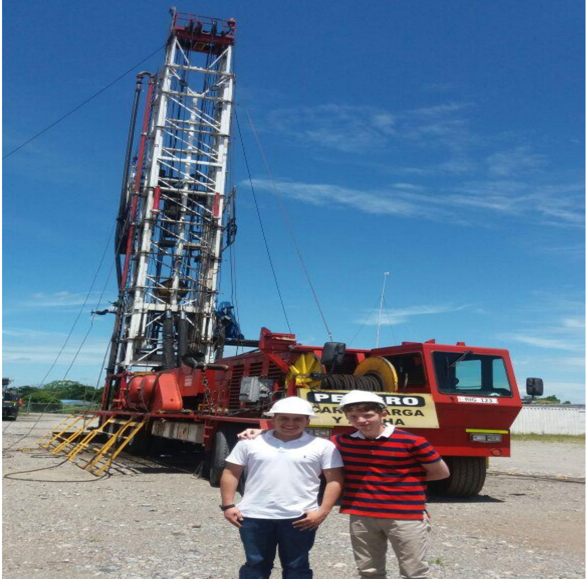
Figura 129. Llegada a campamento base Villavicencio Independence Drilling S.A.
