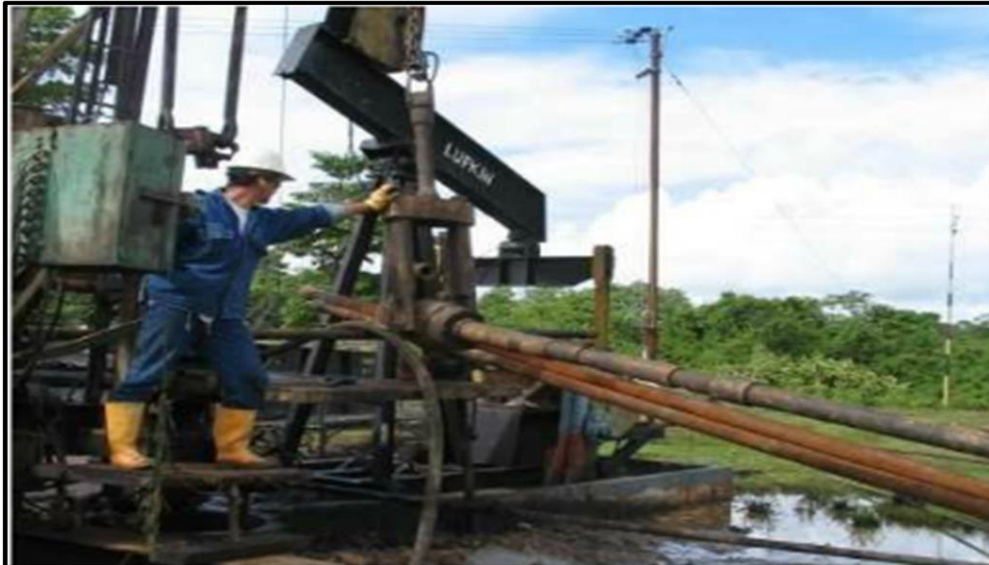
Figura 77. Sacada de sarta de lavado y desinstalación de líneas.
