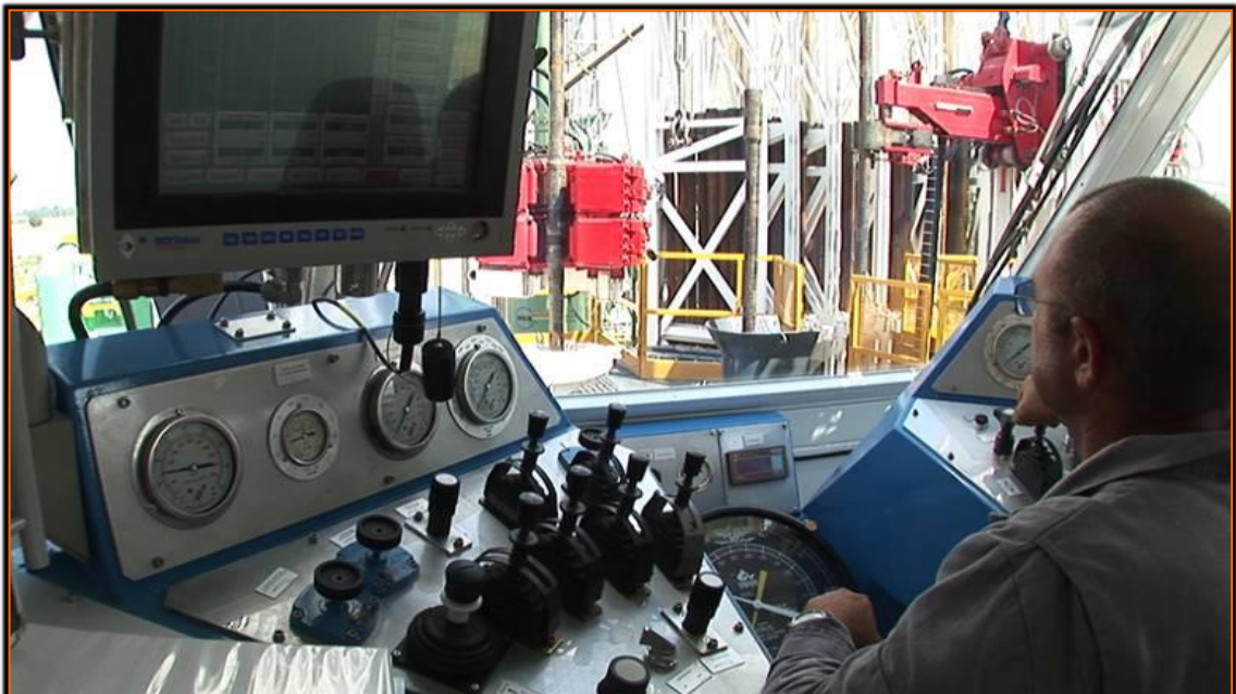
Figura 11. Sistema automático de perforación del RIG 53.
