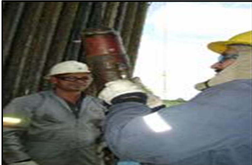
Figura 71. Conexión de stuffing box al sistema hidráulico.
