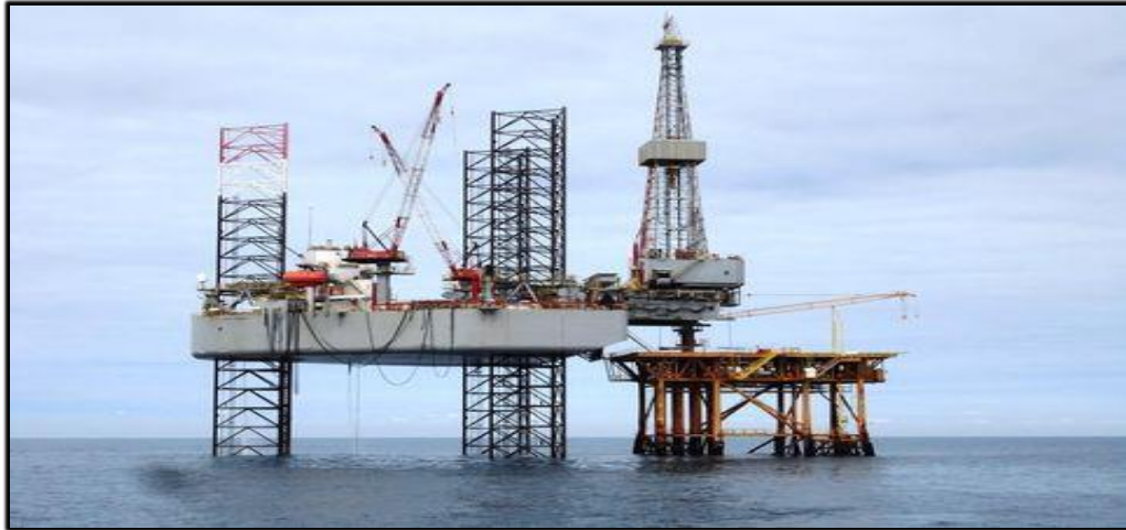
Figura 37. Plataforma auto-elevable de perforación.
