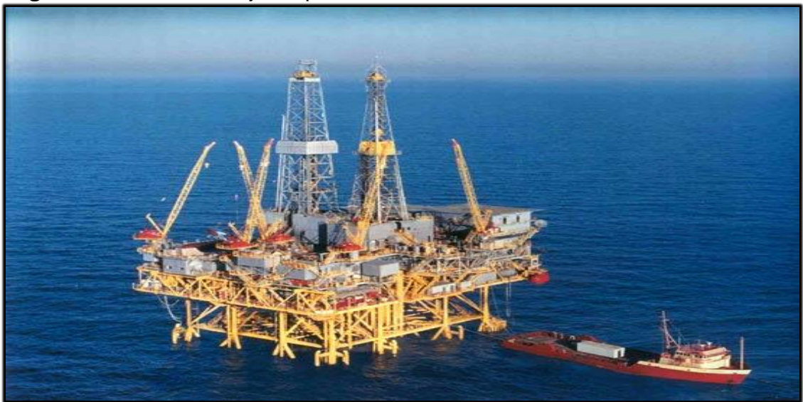
Figura 38. Plataforma fija de perforación.
