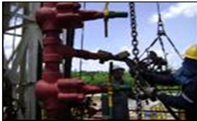
Figura 68. Conexión de líneas al “Choque M.”
