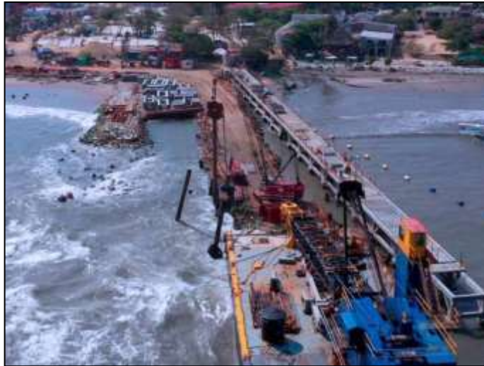
Figura 28. Muelle del puerto de Colombia.
