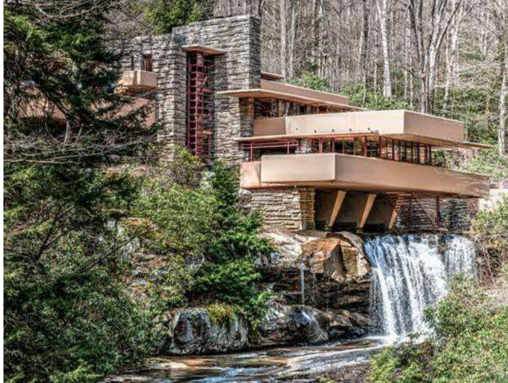
Figura 21. Casa de la cascada - Frank Lloyd Wright
