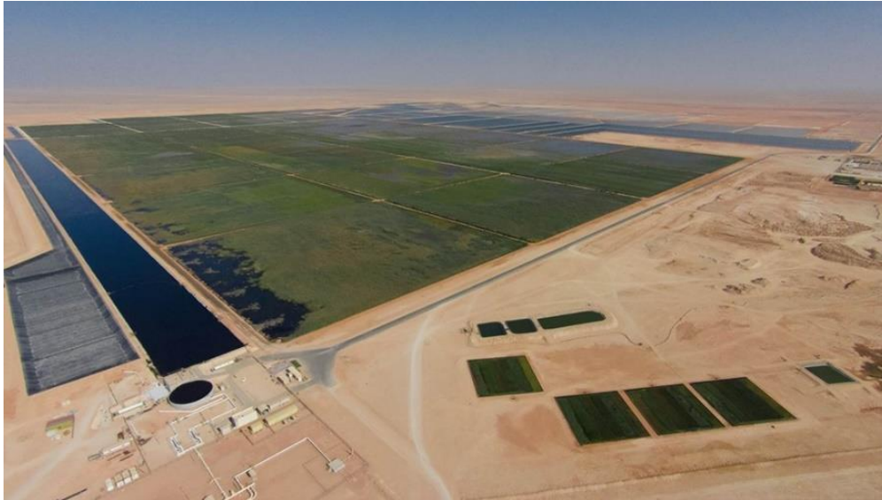
Planta de tratamiento de aguas Bauer Nimr
