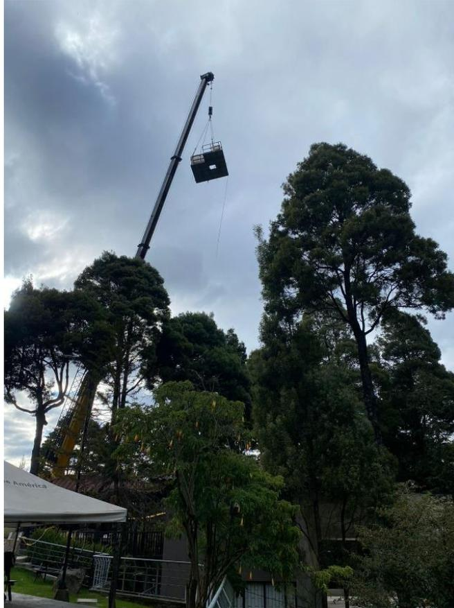
**Nota:** Se evidencia en la Figura 14 el izaje del tercer piso, este corresponde a la unidad de destilación continua, con el fin de poder realizar su respectiva instalación y ensamblaje dentro del edificio.
