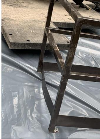
**Nota:** En la Figura 17 se puede evidenciar un daño en la estructura perteneciente al tercer piso de la unidad de destilación continua.
