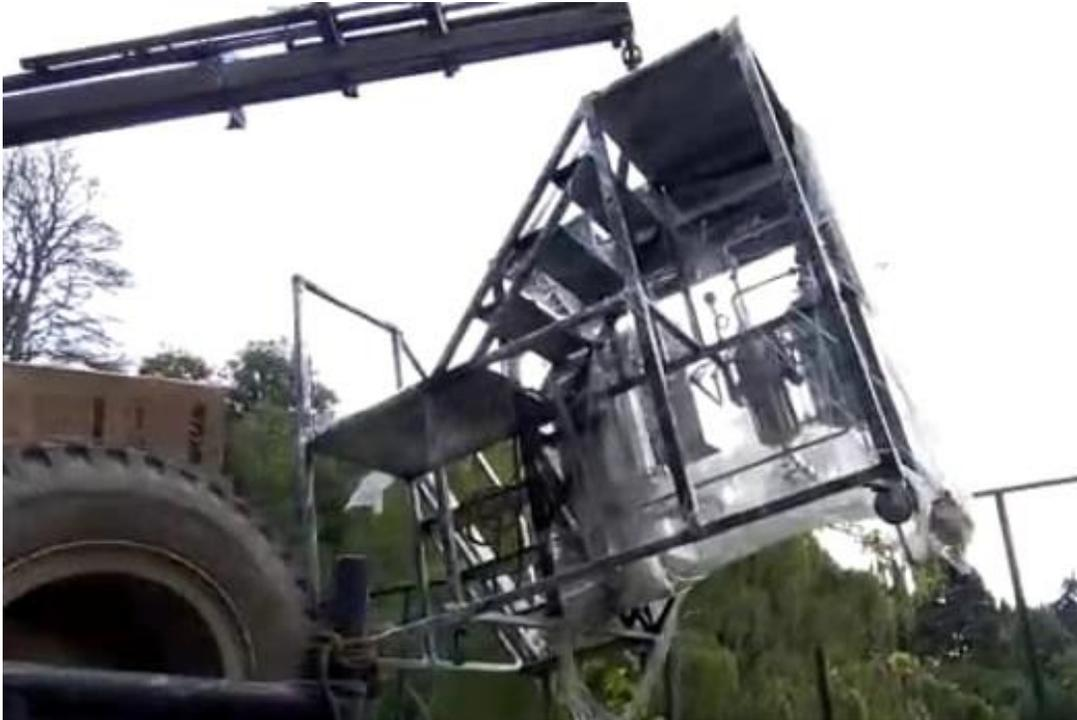
**Nota:** Se aprecia en la Figura 15 el izaje de la estructura correspondiente a la unidad de absorción de gases para poder realizar su respectiva instalación dentro del edificio.
