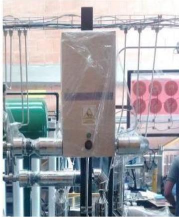
*Nota.* En la figura se puede observar el *sobrecalentador eléctrico*. Obtenido de E. Hernández. “*Planta térmica didáctica*”. Ingenium ingeniería y consultoría LTDA.
