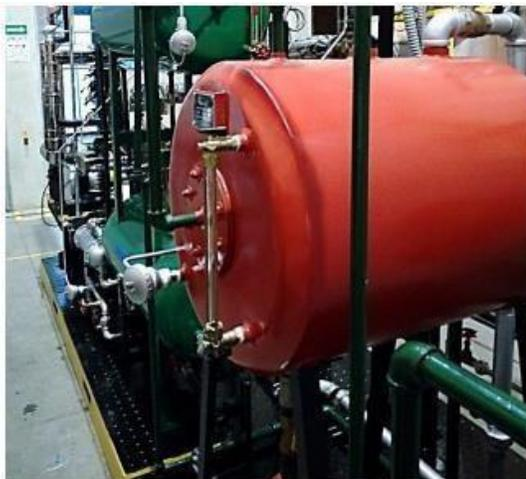
*Nota.* En la figura se puede observar *el* tanque de alimentación de agua y retorno de condensado. Obtenido de E. Hernández. “Planta térmica didáctica”. Ingenium ingeniería y consultoría LTDA.
