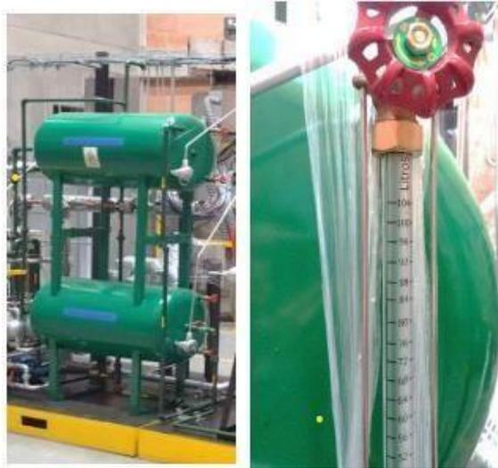
*Nota.* En la figura se puede observar los tanques de agua. Obtenido de E. Hernández. “*Planta térmica didáctica*”. Ingenium ingeniería y consultoría LTDA.
