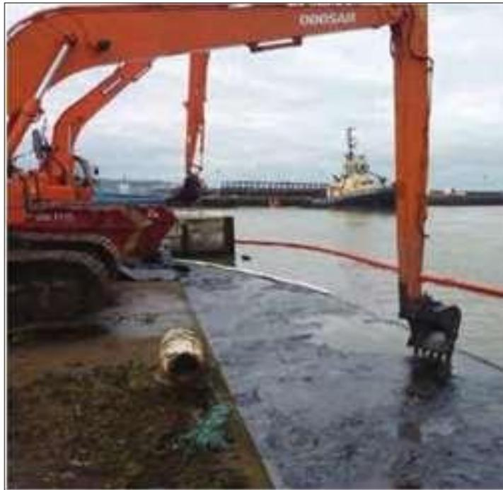
*Nota.* La imagen muestra el proceso de remoción mecánica de crudo pesado. Tomado de ITOPF, (2011a) p.7.
