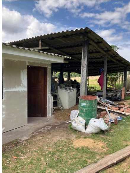
Nota. Imagen exterior zona de ampliación.
