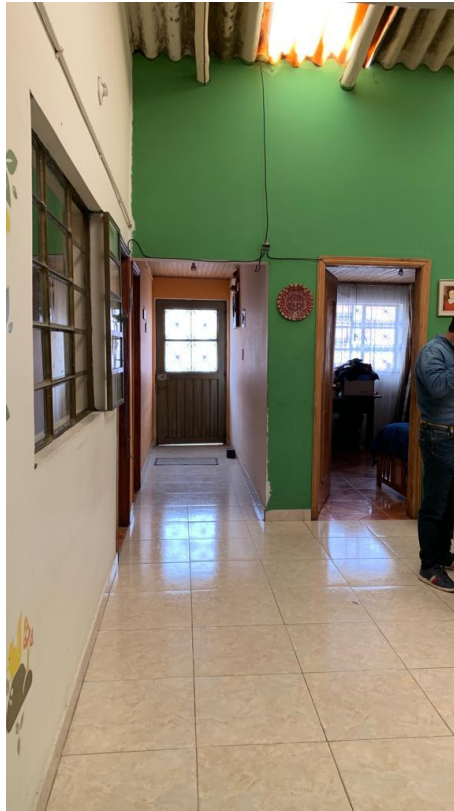
Nota. Imagen interior estado actual.
