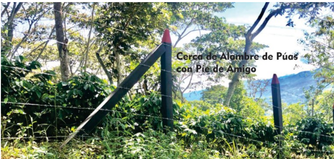
Figura 21. Encerramiento de terreno con pie de amigo
