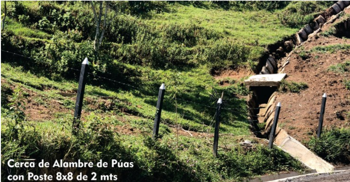
Figura 20. Encerramiento de terreno
