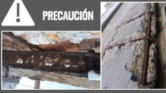
Si presentas corrosión en elementos estructurales como vigas columnas, asesórate de inmediato con un profesional, ya que puede estar en riesgo tu seguridad
