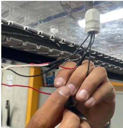
*Nota.* En la imagen anterior se observa una fotografía del proceso de reconexión de las electroválvulas al sistema.
