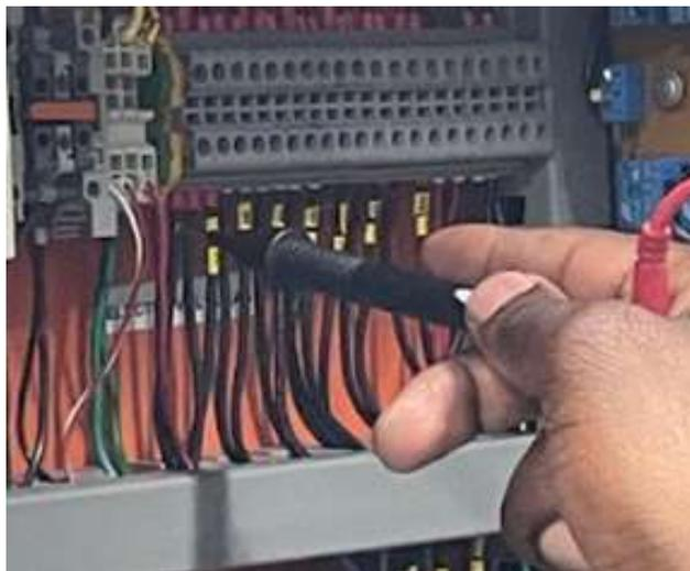
**Nota.** En la imagen anterior se observa una fotografía de la medición de continuidad en zona de motores.
